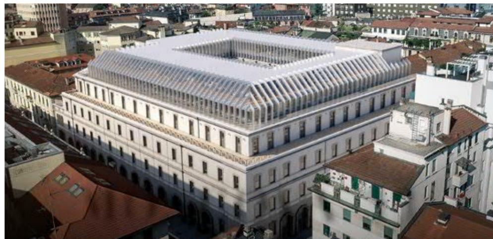
Attività realizzate: Demolizioni e scavi; Strutture in c.a.; Consolidamenti strutture esistenti; Murature ed intonaci; Carpenterie metalliche e grigliati; Trattamenti Rei; Facciate e serramenti esterni; Opere edili a secco (pareti in cartongesso e controsoffitti); Sottofondi; Pavimenti e rivestimenti; Opere pietra; Coibentazioni ed impermeabilizzazioni; Opere da fabbro; Impianti meccanici; Impianti elettrici e speciali; Tinteggiature.
