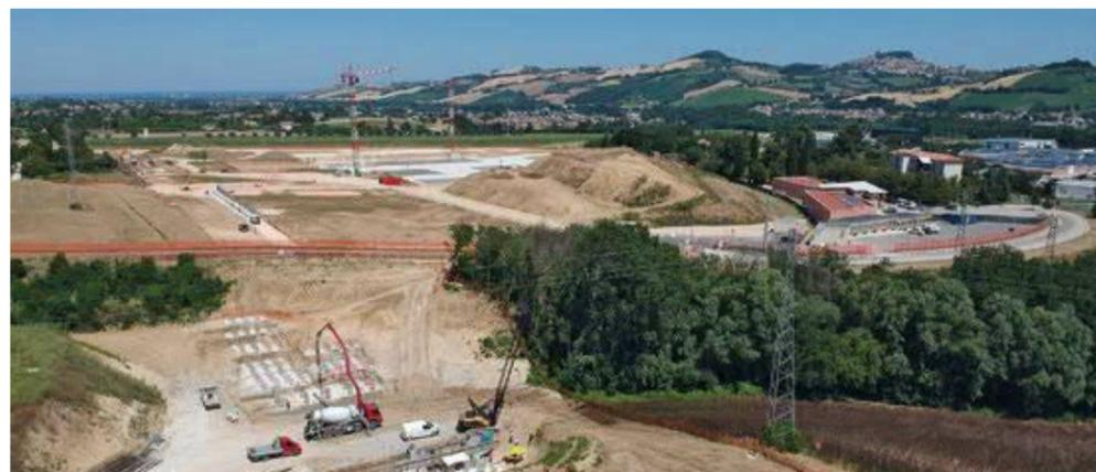
Attività di progettazione esecutiva, opere preliminari di indagine archeologica e sono state eseguite le opere propedeutiche quali il consolidamento del terreno mediante inclusioni rigide, eseguiti gli scavi e gli sbancamenti generali e il getto del magrone di sottofondazione; per quanto riguarda l'appalto complementare della viabilità di collegamento si è conclusa l'attività di progettazione esecutiva.
