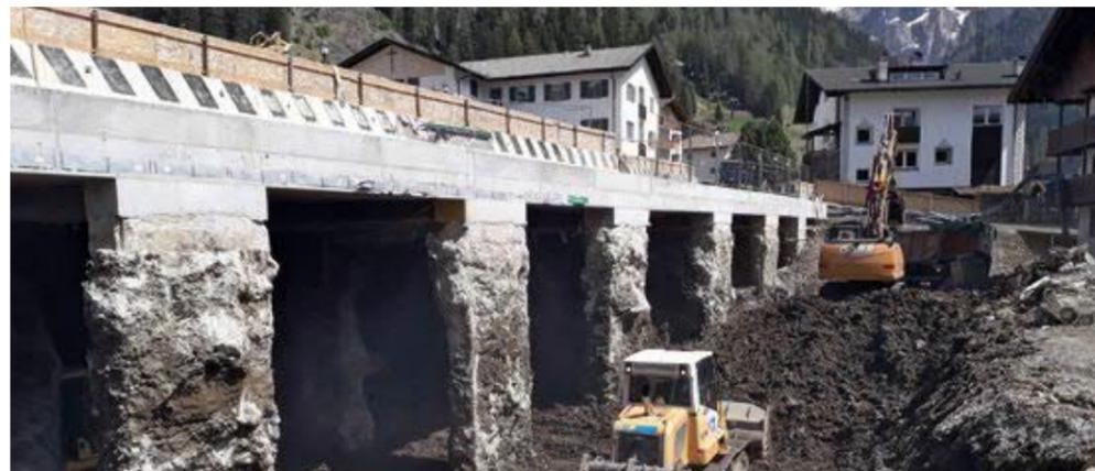
Attività realizzate: opere di sostegno allo scavo mediante diaframmi e realizzazione delle opere in cemento armato e di impermeabilizzazione.
