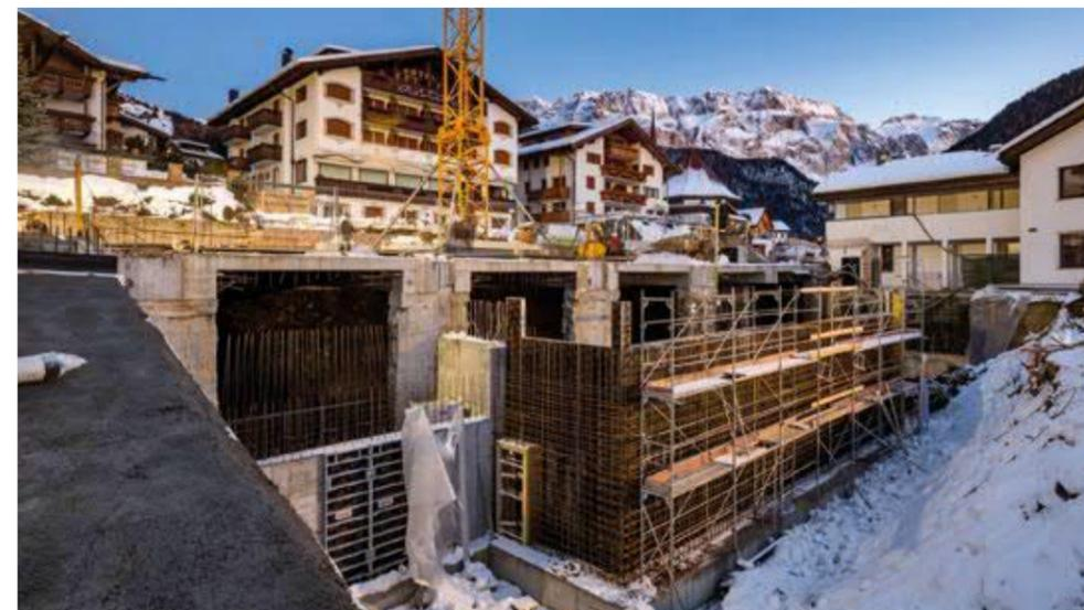
Attività realizzate: opere di sostegno allo scavo mediante diaframmi e realizzazione delle opere in cemento armato e di impermeabilizzazione.
