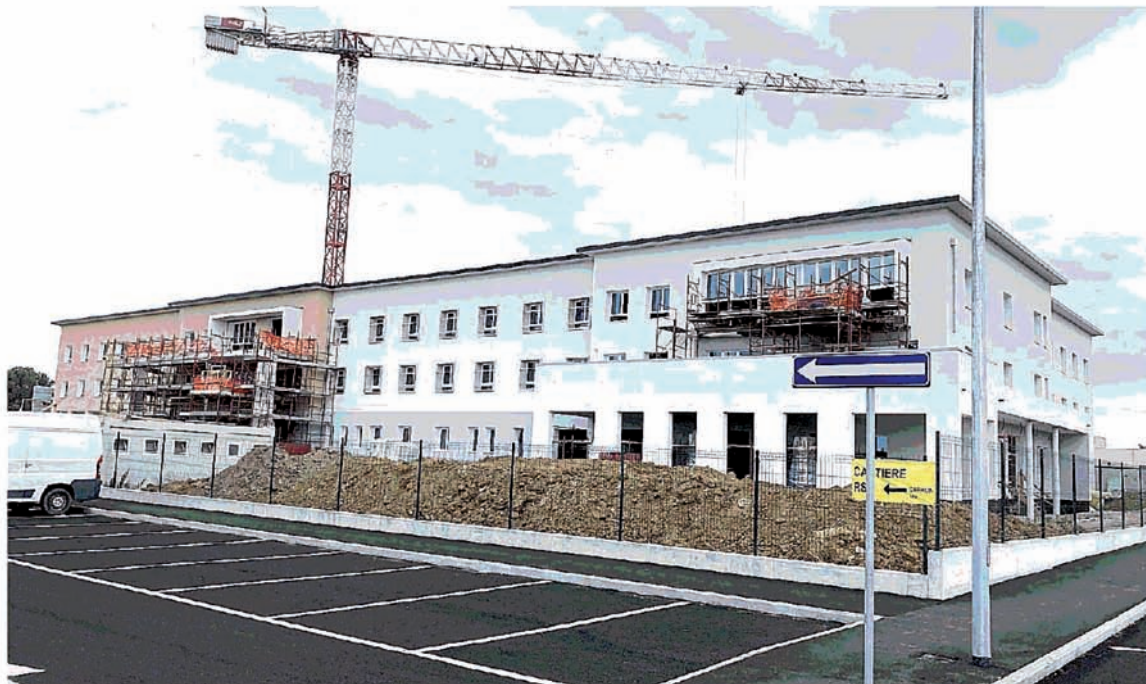
Il cantiere aperto al Paratino per la costruzione della residenza sanitaria assistenziale (FOTO MICHELE FALORNI - SILVI)
