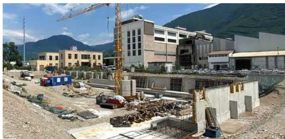
Nel 2020 sono stati affidati i lavori propedeutici alla realizzazione dell'ampliamento degli edifici adibiti a laboratori per l'avviamento delle start-up del NOI di Bolzano. Le opere riguardano la realizzazione di un muro di contenimento necessario per un futuro lotto non ancora appaltato necessarie per poter poi spostare la linea della SNAM.
