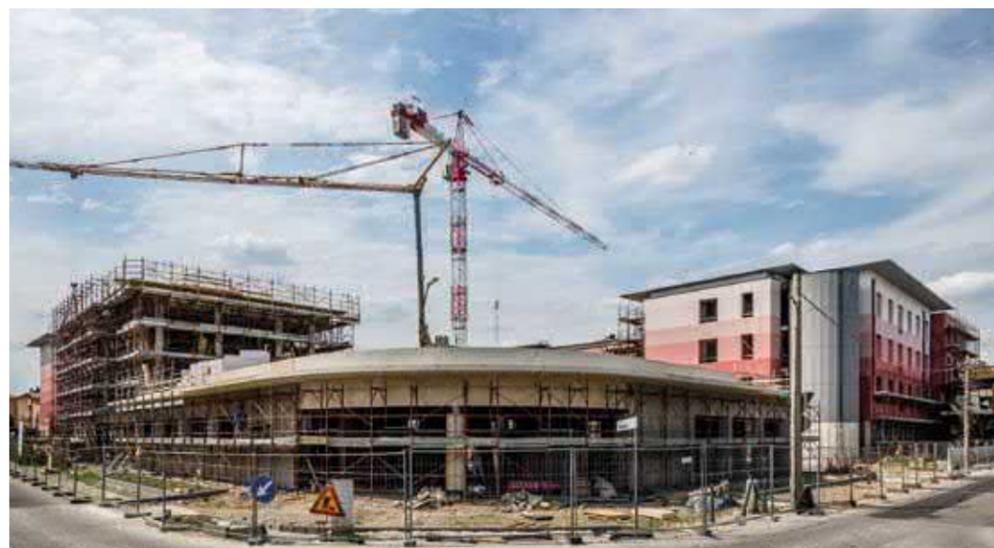
Attività realizzate: Scavo; Strutture in cemento armato; Inizio muri perimetrali; opere in cartongesso. Impianti elettrici e meccanici; Opere di urbanizzazione.
