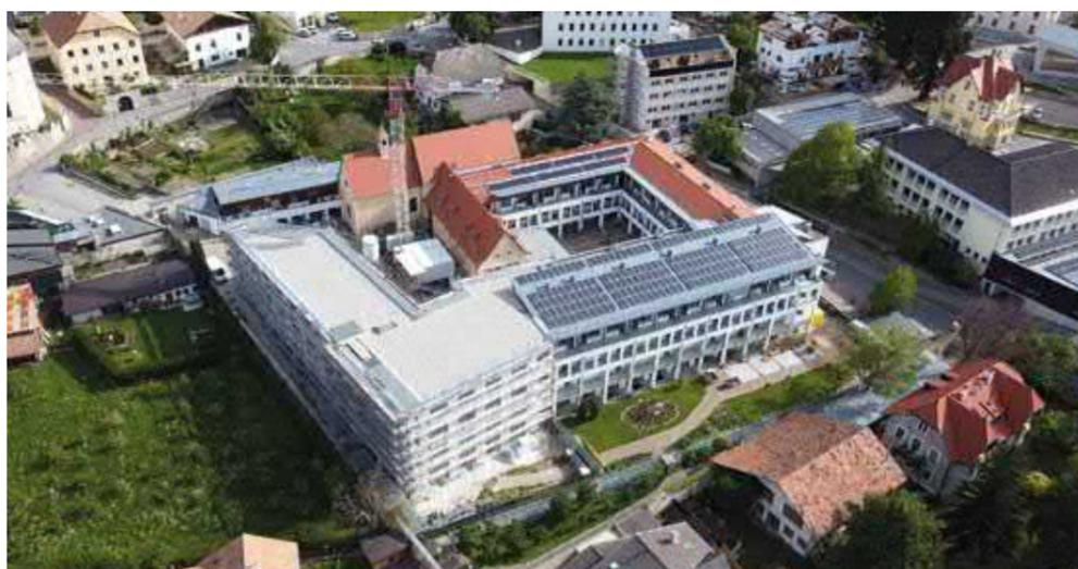
Nel corso del 2020 sono state eseguite le opere di demolizione, scavo, fondazioni speciali, struttura grezza ed impermeabilizzazione.
