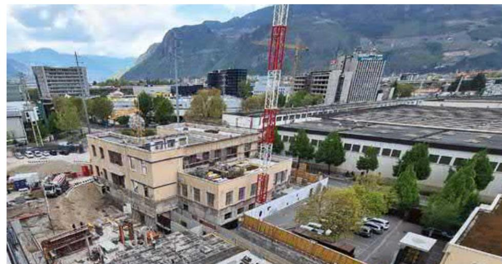
Nel 2020 è stato acquisito questa nuova commessa che nel 2020 ha realizzato le opere di accantieramento di demolizione e strip-out dell'edificio esistente oltre alla realizzazione delle opere di fondazione speciale.
