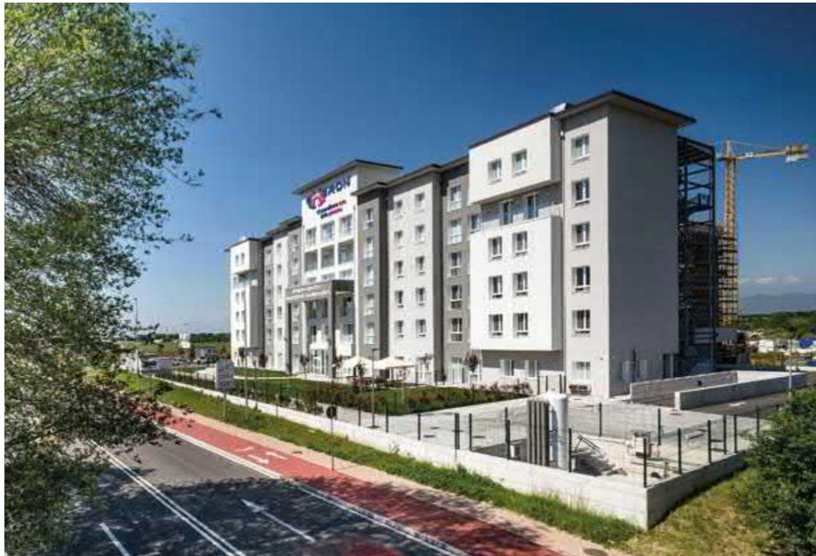
Neubau in rechteckiger Form, bestehend aus einem Untergeschoss von etwa 1.500 qm und 6 oberirdischen Stockwerken mit einer Gesamtfläche von etwa 10.000 qm.
