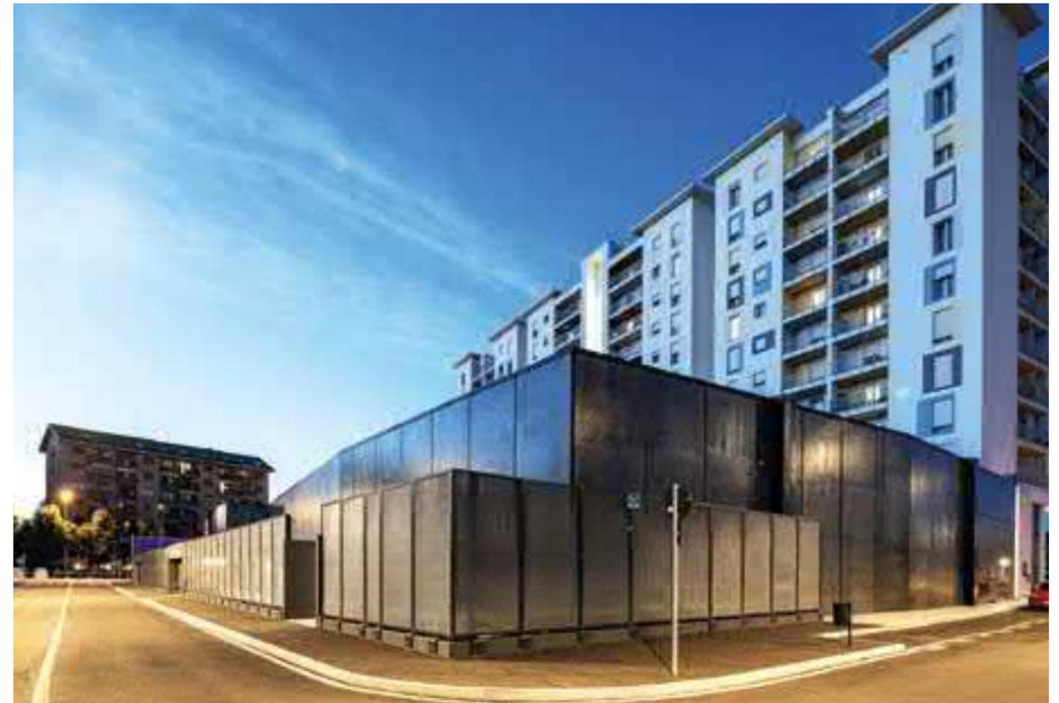
Gli interventi in oggetto hanno riguardato i lavori di costruzione del complesso edilizio di strada della Pronda a Torino. Il primo lotto ha visto la realizzazione di un edificio costituito da 11 piani fuori terra e 2 livelli interrati. I piani fuori terra (dal livello 1 al livello 11) ospiteranno invece appartamenti residenziali (social housing), per complessivi 129 alloggi. Nei 2 piani interrati, infine, saranno dislocati 129 box singoli pertinenti la residenza (secondo piano interrato).
