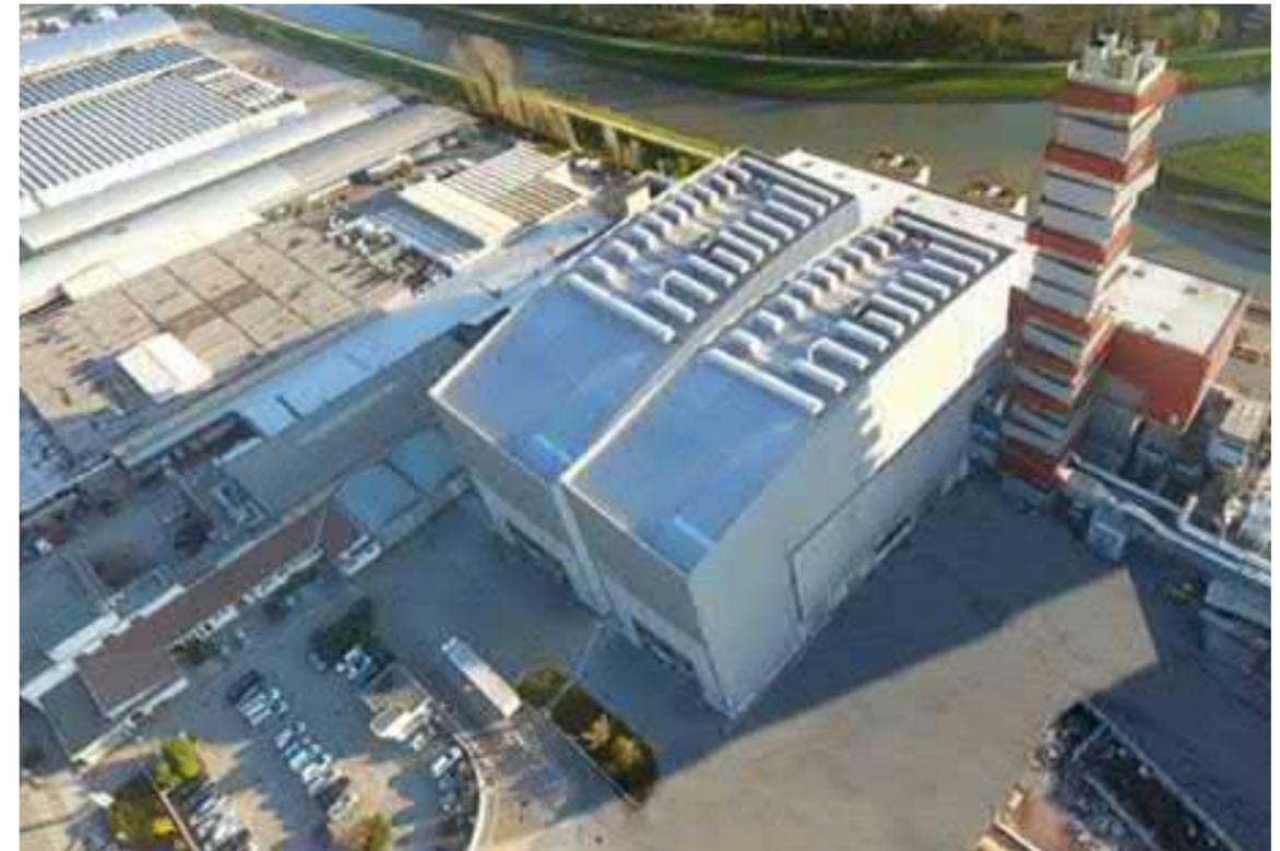
Die Baumaßnahme sieht die Realisierung der neuen Linie 4 des Heizkraftwerks (WTE) Padua vor, die über die gleiche Leistung wie die bestehende Linie 3 verfügt, sowie aller notwendigen Nebenbauten und hiermit verbunden Bauten. Insbesondere hat der Auftrag die Bauausführungsplanung, die Ausführung der Bauten und BOP (Balance of Plant) zum Gegenstand.
