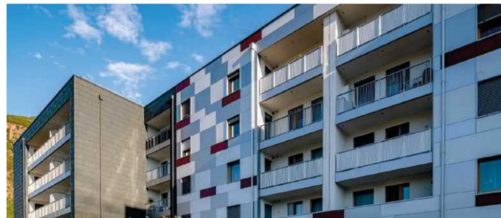
Riqualificazione energetica di 72 appartamenti che rimangono abitati durante i lavori, opere di riqualificazione rispettando le normative "CasaClima A", nuova facciata con pannelli prefabbricati in legno, sistema misto per riscaldamento e ACS: pompa di calore geotermica + integrazione con caldaia, solare fotovoltaico più solare termico, ventilazione meccanica con sistema decentrato per ogni appartamento.
