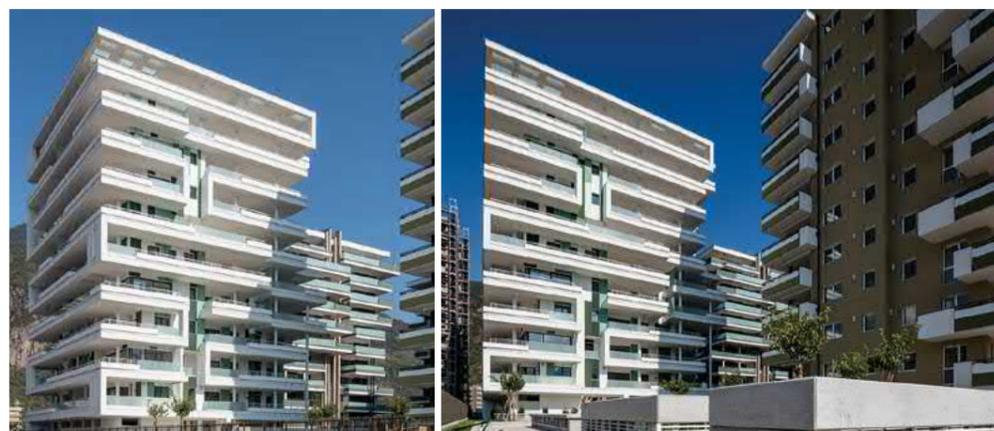
Nuova costruzione secondo le normative "CasaClima NATURE" con elevati standard igienici e una gestione attenta dei rifiuti, altezza dell'edificio pari a 34m con 11 piani fuori terra, cantiere circondato da altri lotti realizzati contemporaneamente (non di ns. competenza), due grandi interrati con solaio quota 0 impermeabile (sistema Zementol).
